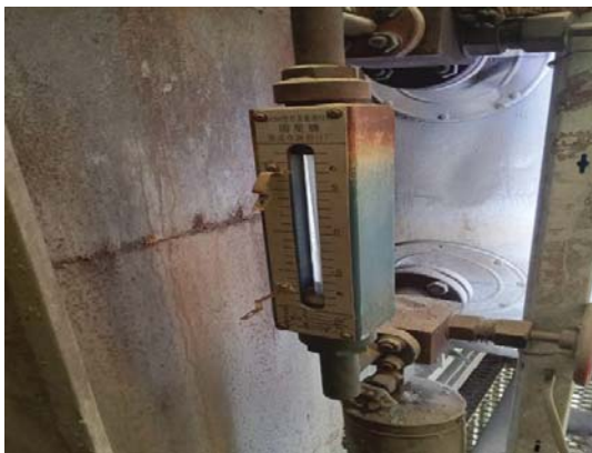
ภาพที่ 26 เครื่องวัดระดับน้ำชนิดหลอดแก้ว
