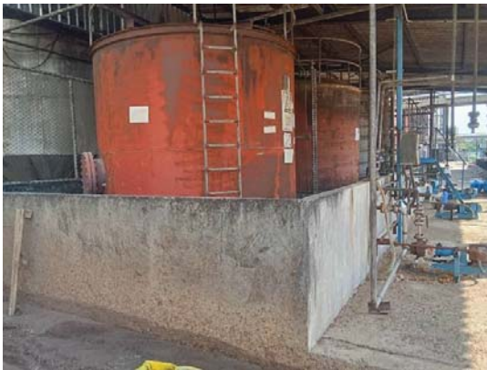
ภาพที่ 20 คันคอนกรีตล้อมรอบถังเก็บสารเคมี
