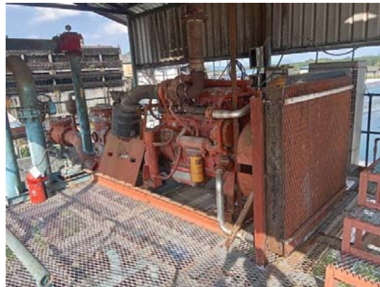
ภาพที่ 21 ระบบป้องกันและระงับอัคคีภัย เช่น Fire Emergency, Fire Pump ถังดับเพลิง
