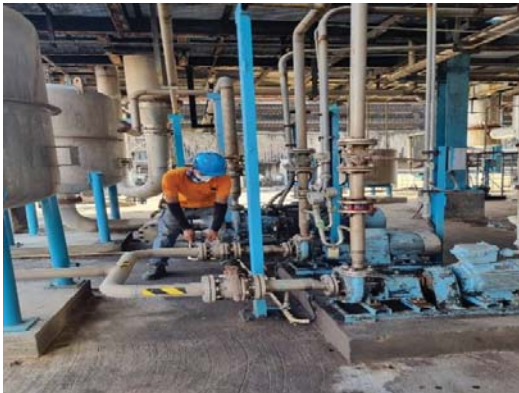
ภาพที่ 24 เจ้าหน้าที่ตรวจสอบสภาพถังระบบท่อข้อต่อ และวาล์ว
