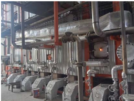
ภาพที่ 32 ฉนวนหุ้มท่อจ่ายไอน้ำและลิ้นปิดเปิด (Blow Down)
