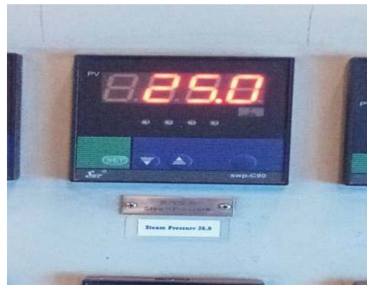
ภาพที่ 27 เครื่องวัดความดันไอน้ำ
