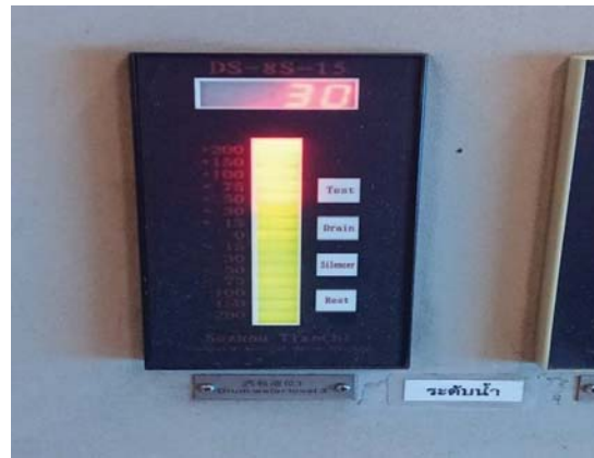
ภาพที่ 31 สัญญาณเตือนอัตโนมัติ (automatic Alarm) แจ้งเตือนรายเมื่อระดับน้ำในหม้อไอน้ำต่ำกว่าระดับ ใช้งาน
