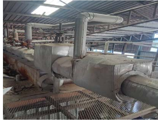
ภาพที่ 29 ลิ้นจ่ายไอน้ำ (Main Steam Valve)
