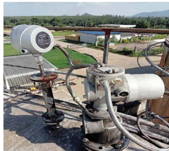
ภาพที่ 4 เครื่องวัดระดับ low Level transmitter และ High Level transmitter ของถังเก็บสำรองเอทานอล
