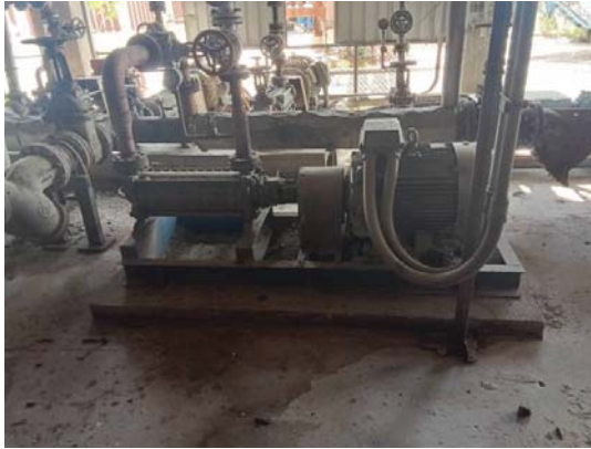
ภาพที่ 28 Boiler feed Water Pump
