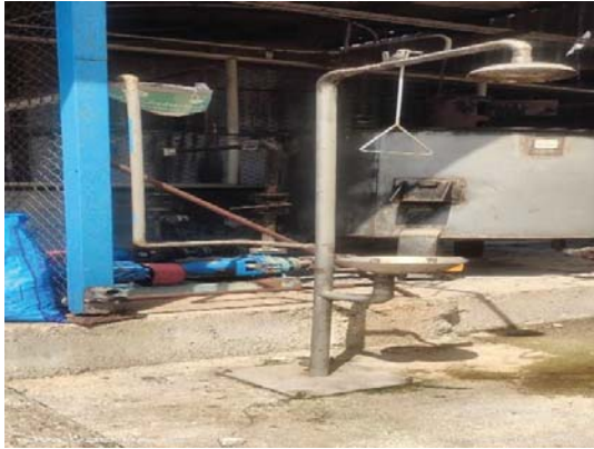
ภาพที่ 18 อ่างล้างตาและฝักบัวฉุกเฉิน
